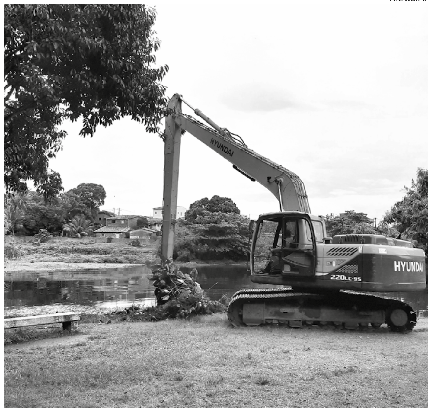
Draga está retirando do leito do lago existente no parque restos de vegetação, que contribuem para acumular areia e reduzir a sua profundidade
